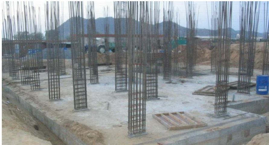
Hình 2.13 Móng bè sau khi thi công xong
