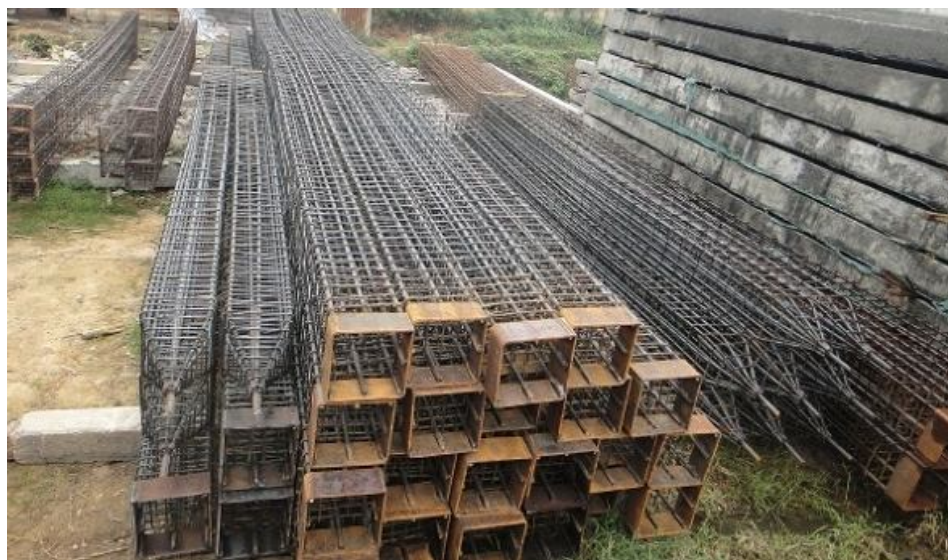
Hình 3.8 Công trường thi công thép cọc.
