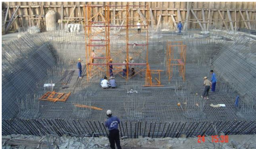
Hình 2.14 Móng bè trên cọc khoan nhồi.
