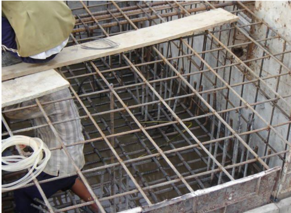
Hình 3.15 Thi công thép đài cọc.
