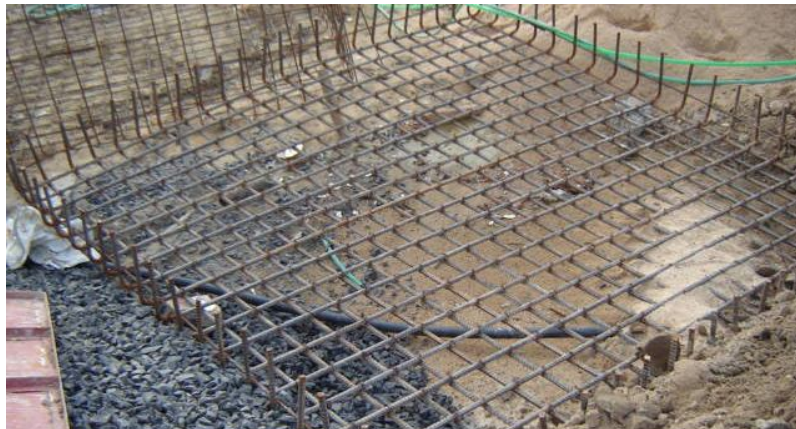
Hình 3.13 Lưới thép chịu lực bên dưới đài cọc.
