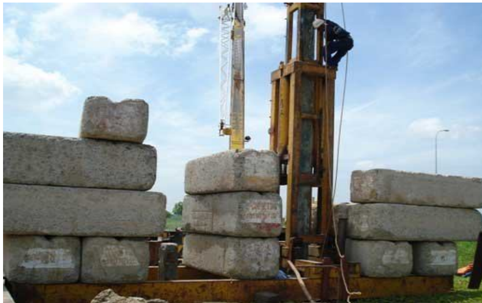
Hình 3.11 Thi công cọc ép
