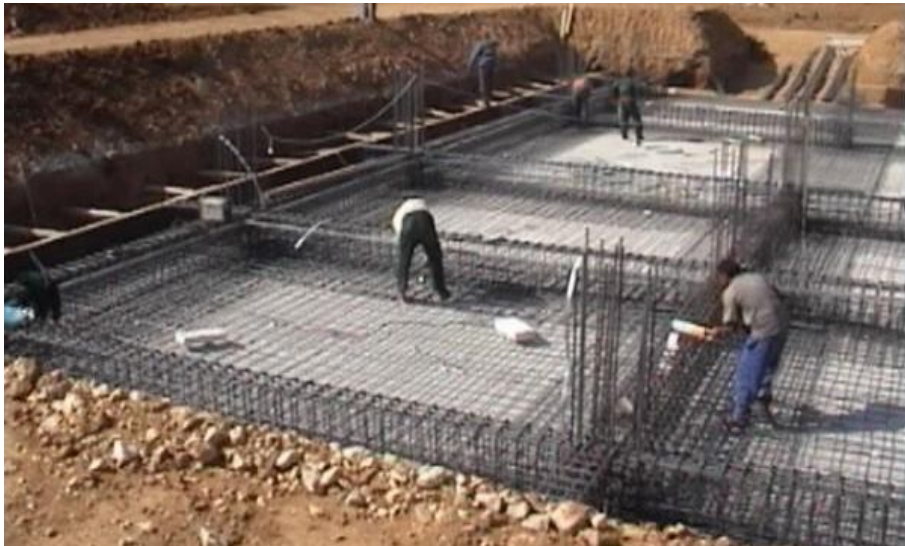
Hình 2.12 Thi công thép móng bè.
